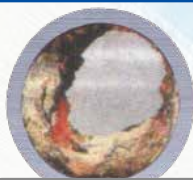
錆びた金属管の内部
